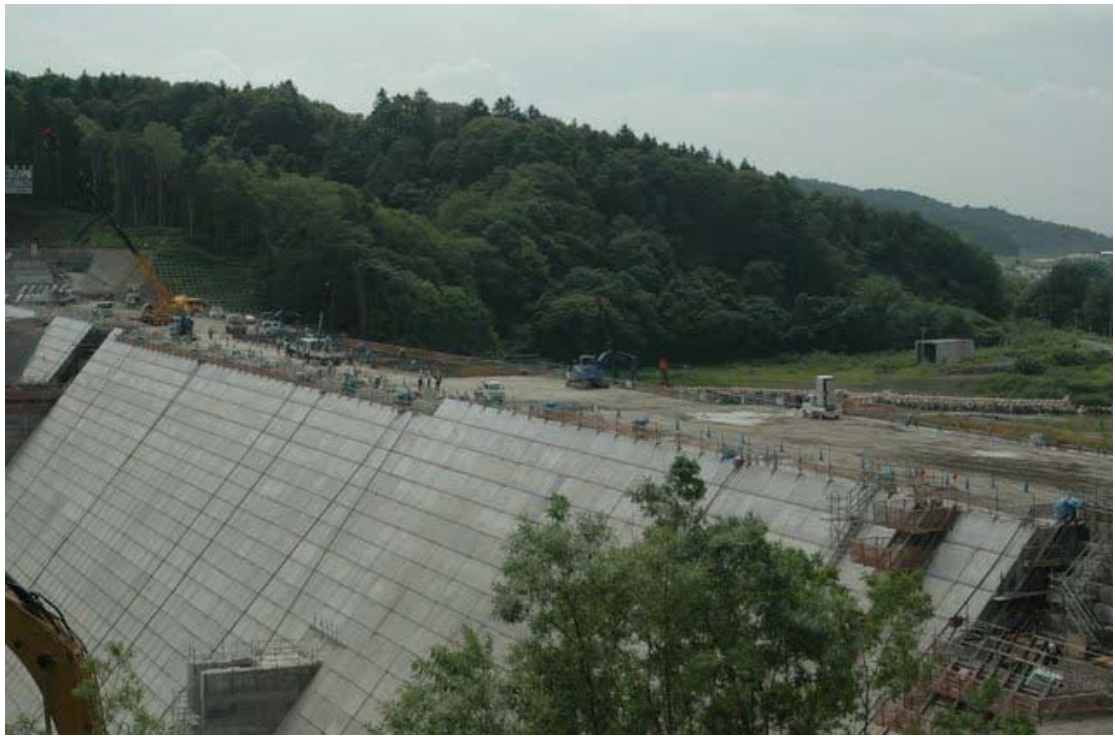
[当別ダム・工事現場]
